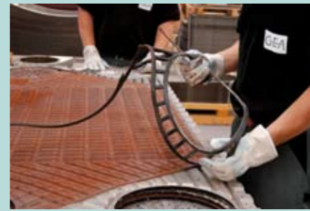
2. Gründliche Entfernung der alten Dichtung
